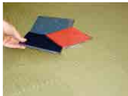
12. Nastavek vložiti brez tesnila, položiti talno oblogo
