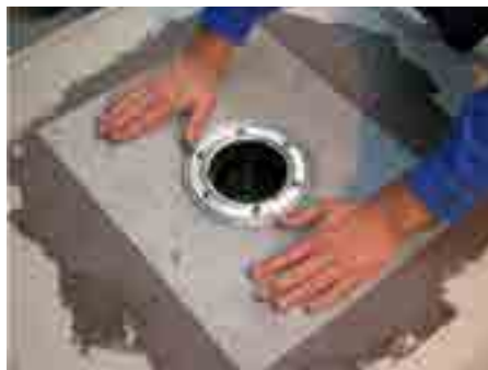
8. Folijo zgladiti 9. Hidroizolacijski premaz nanesti po celotni izolacijski površini.
