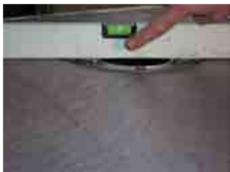
10. Možnost polaganja ploščic brez problema: celotna tesnilna garnitura se nahaja pod gornjim robom estriha
